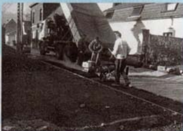
Parking rue Briquet
