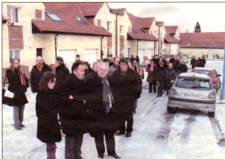
Rue Mercier, Pas-de-Calais habitat a construit 16 nouveaux logements.
