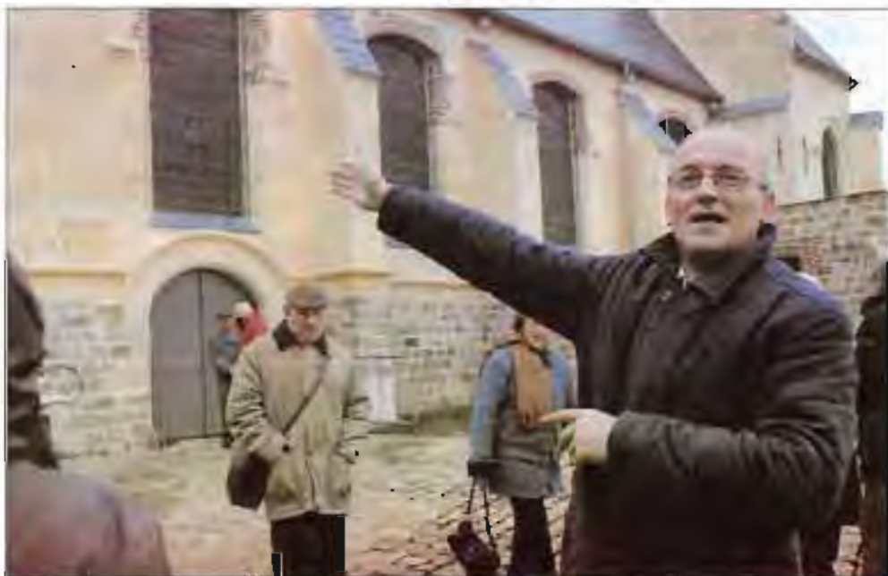
Les façades sud et nord ont été nettoyées : l'église retrouve son éclat d'antan. Avec la démolition d'une ancienne annexe, elle redevient visible depuis la rue.
